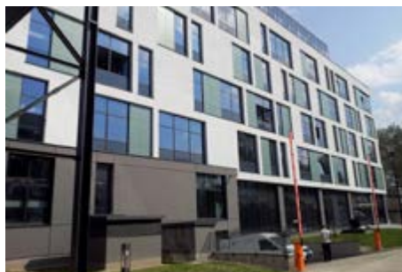
Centrum Nauk Biologiczno-Chemicznych UW CENT III, Warszawa
