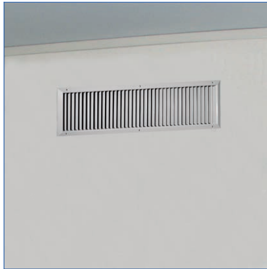
Montaż w ścianie
